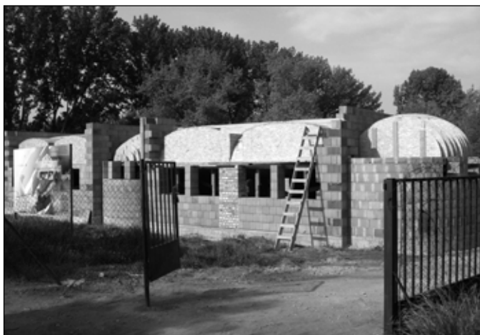
A dongaboltozat és a félkupola építése komoly zsaluzást kíván
